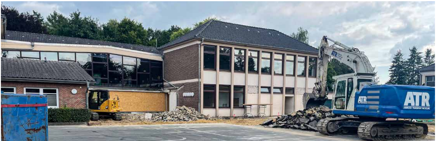
Bauarbeiten an der Lintler Geest-Schule in Bendingbostel.
